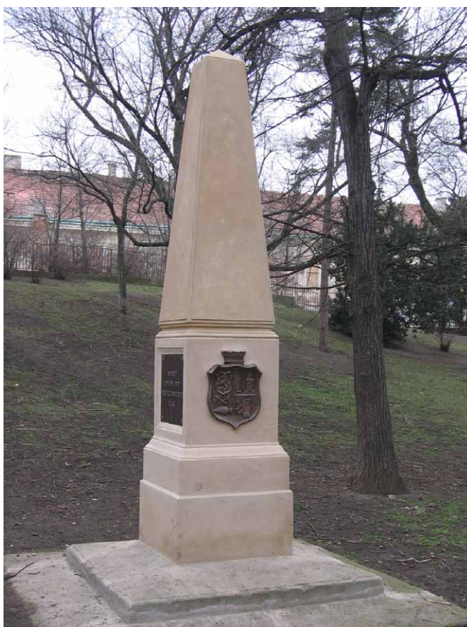
Opravený pomník povýšení Vršovic na městys
