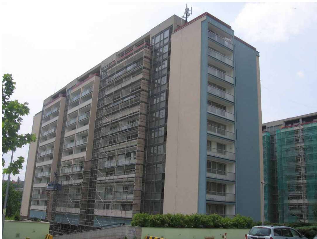
Sanace panelových domů – sídliště Vlasta
