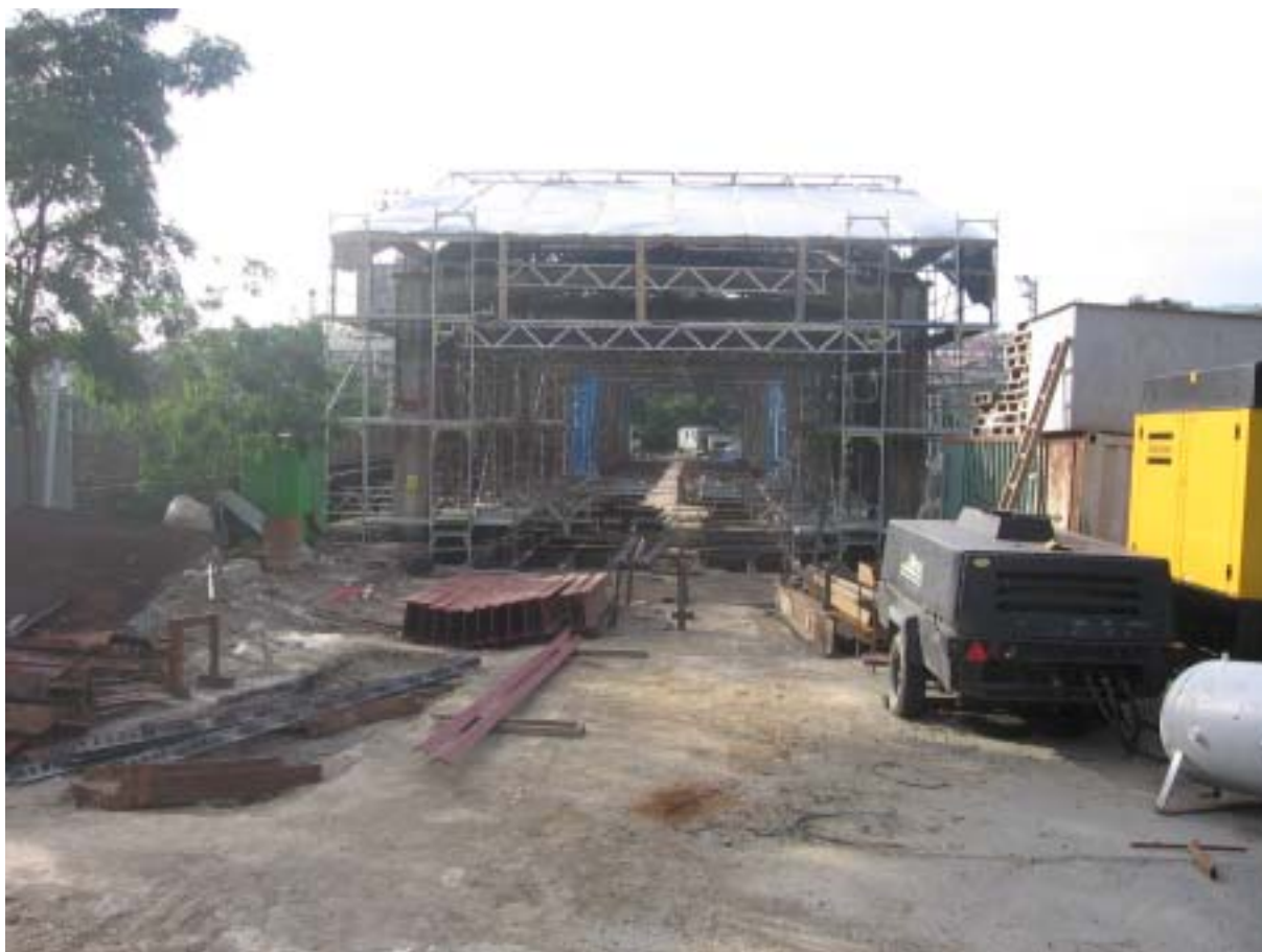
Oprava mostu nad železniční tratí
