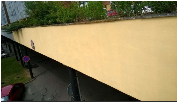
Obr. č. 17 – opravený stav
