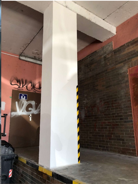
Obr. č. 20 – opravený stav
