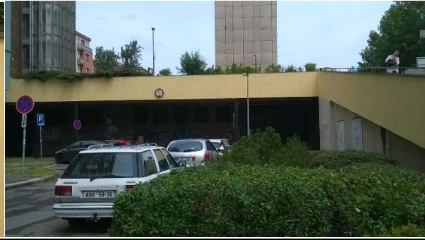
Obr. č. 18 – opravený stav
