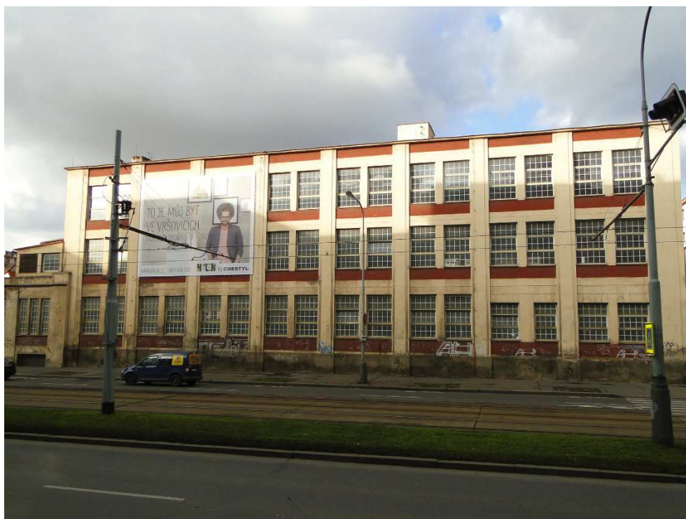
Areál bývalé firmy Tesla má ustoupit projektu 4Blok
