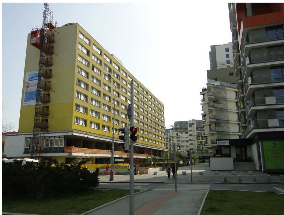
Přestavba „Malešického penzionu“
