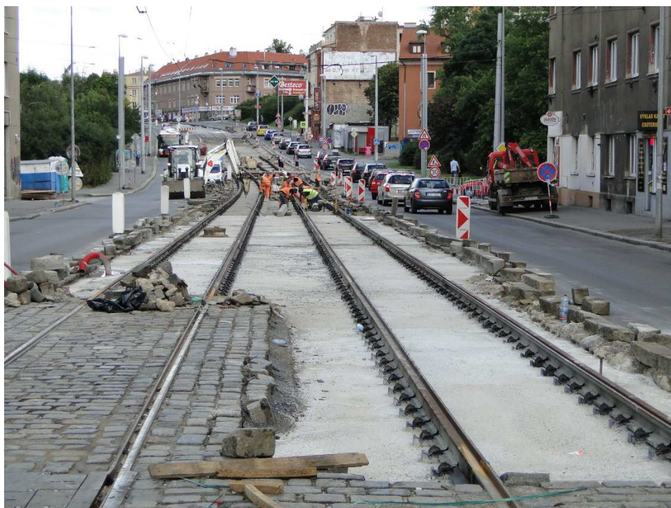
Rekonstrukce kolejí v ulici Průběžná
