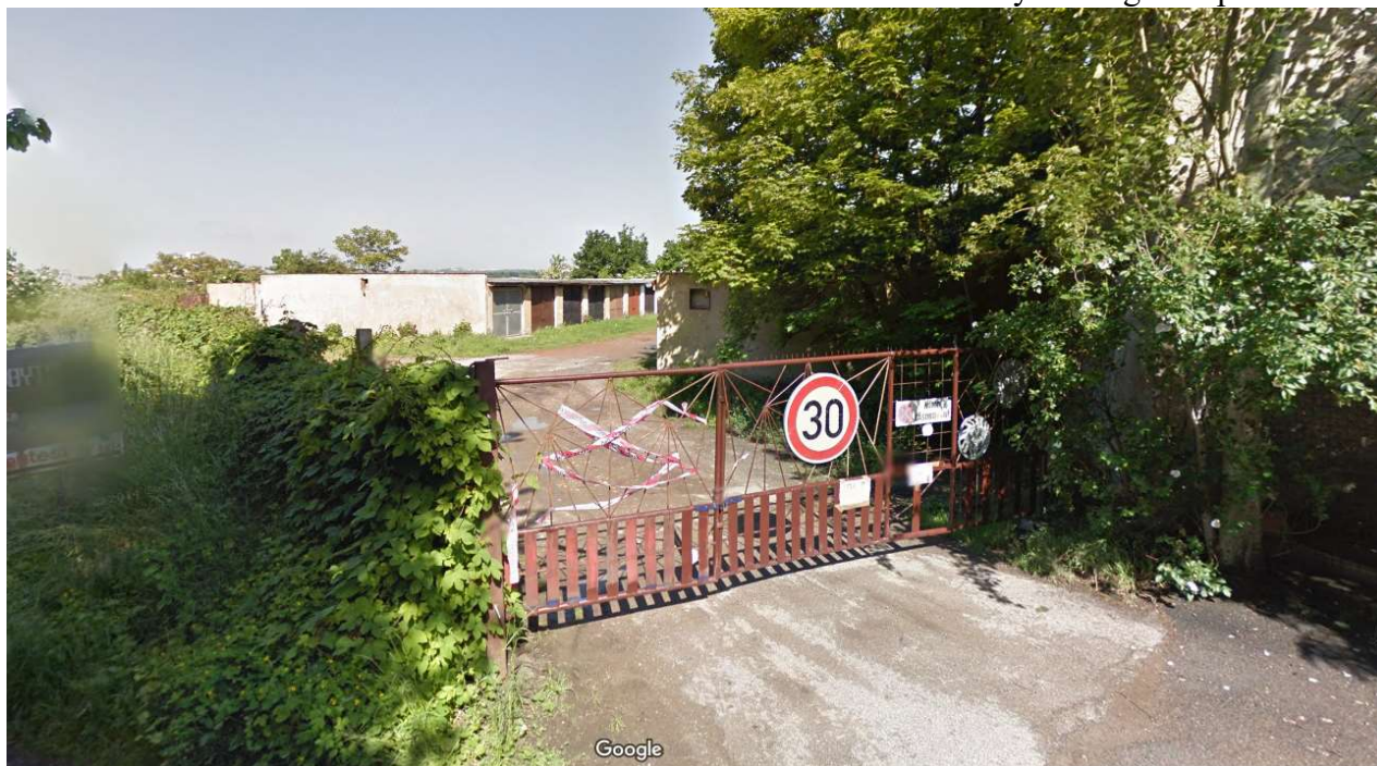
pohled na vjezd do areálu garáží z ulice Křeslická
