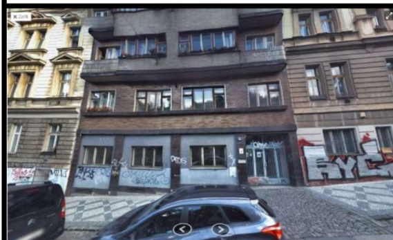
Francouzská 62 - garáže ve vnitrobloku
