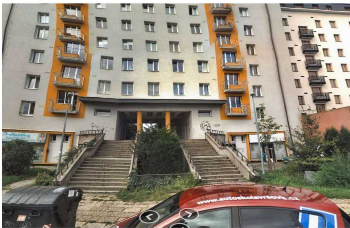
Schodiště a průchod domem v ulici Bělocerkevská 1299, 1301, Praha 10
