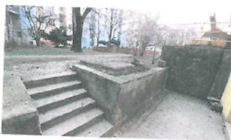
Pohled na venkovní schodiště a dvorní dlažbu
