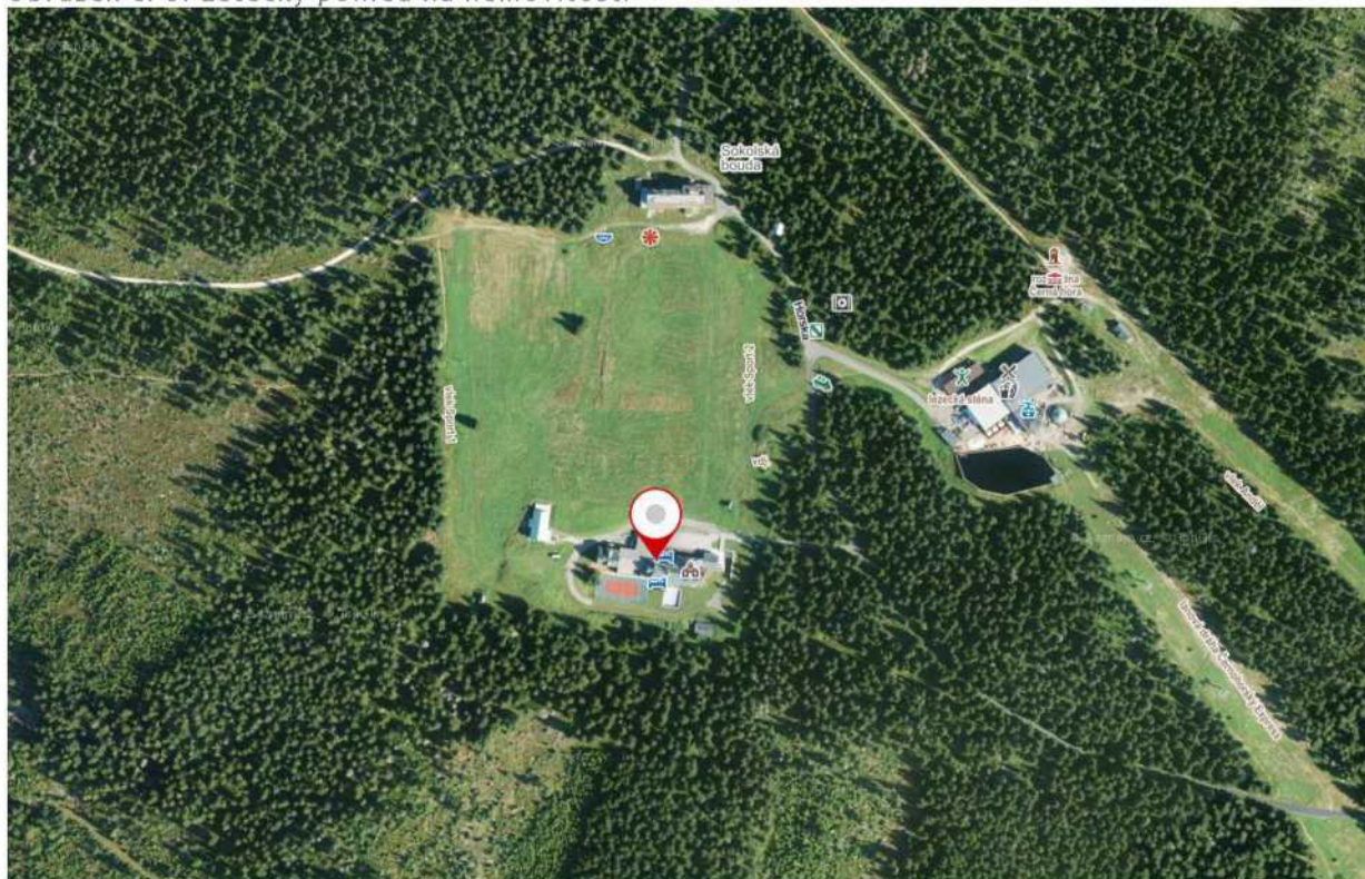
Obrázek č. 6: Letecký pohled na nemovitosti
