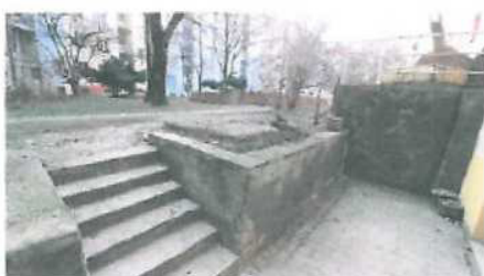
Pohled na venkovní schodiště a dvorní dlažbu
